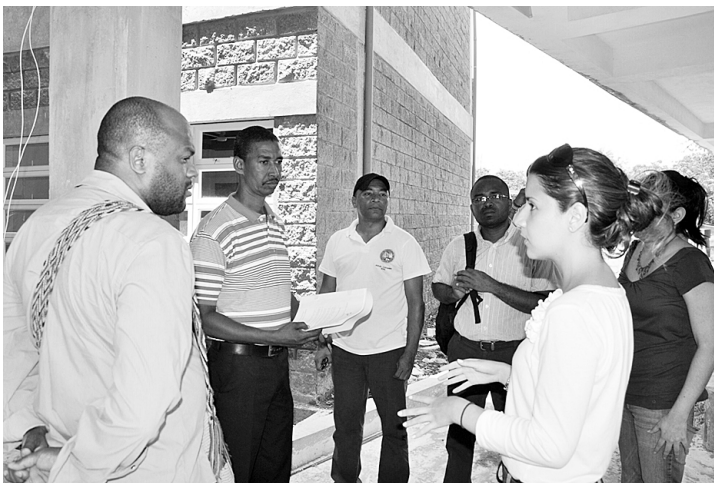
SUSANA Ríos, arquitecta supervisora de la obra les informó que simultaneo a estos trabajos, se adelanta una segunda fase, que tiene un costo de $ 1.370 millones para construir el aula múltiple, cocina, sala de audiovisuales, biblioteca y sala de sistemas.
